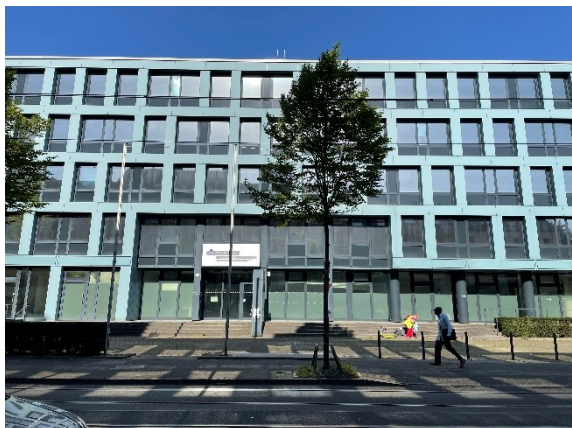
Abbildung 3: Gebäude der ehem. Unfallkasse NRW
