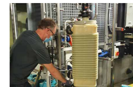
Einbau des neuen Wärmetauschers im Filterkeller
