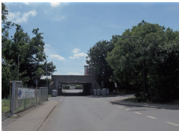
Unterführung des Aderkirchweges unter dem Südring
