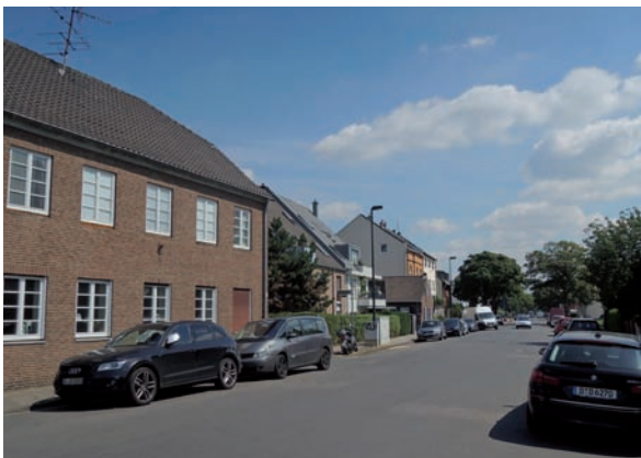
Bebauungsstruktur an der Fährstraße
