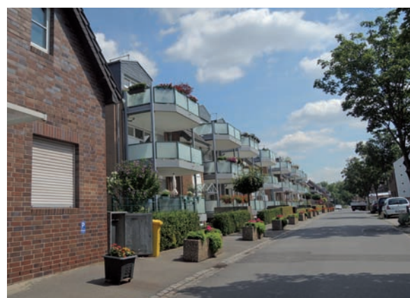
Bebauungsstruktur an der Straße Auf der Böck
