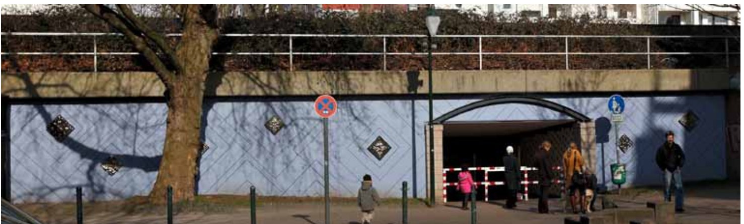
Neue Gestaltung der Unterführung Wetterstraße
