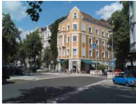
Einengung und Aufpflasterung der Straßeneinmündungen
