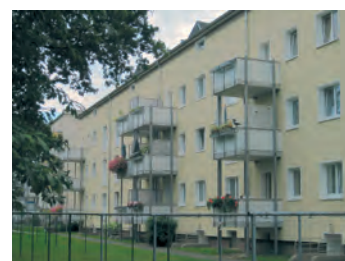
Säckinger Straße nach der Sanierung
