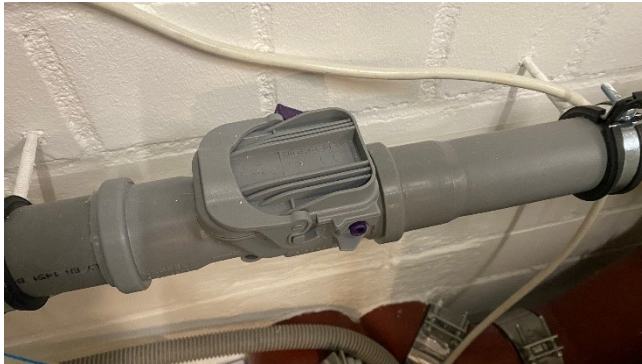
Rückstausicherung (Klappe) für Waschbecken, Waschmaschinen etc.
