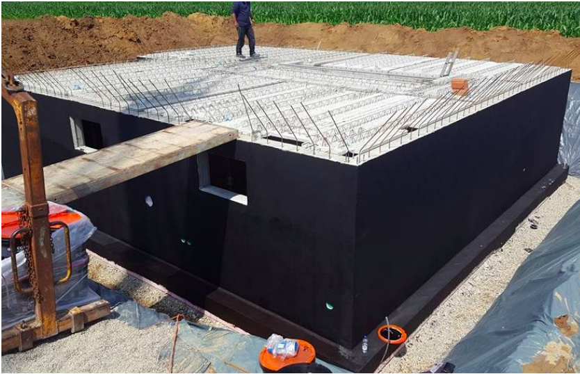
Abdichtung Bodenplatte/Kellerwände (Schwarze oder weiße Wanne)
