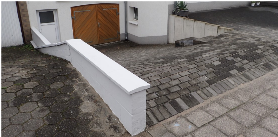
Aufpflasterung der Einfahrt
